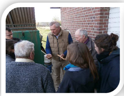
Présentation du bois déchiqueté dans la chaufferie
